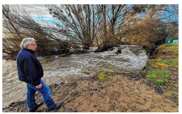
Tilo Schneckenburger begutachtet die Böschung auf dem Gelände des Windsurfclubs in Nußdorf. Bevor der Nußbach hier in den Bodensee mündet, steht ein jetzt überschwemmter Biberbau, der für zusätzlichen Wasserdruck sorgt, wodurch die Böschung unterspült wurde. | Bild: Hilser, Stefan
